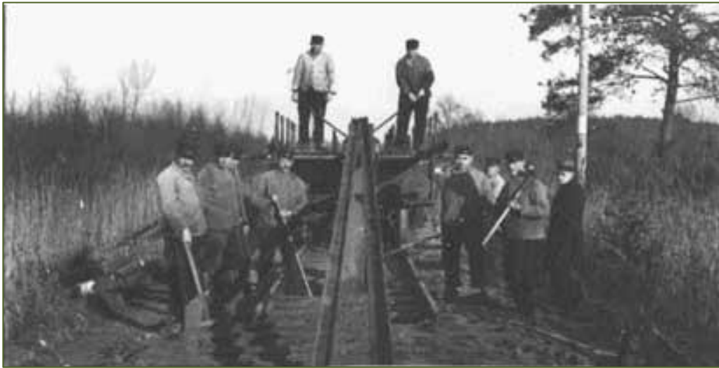
Figuur 9. Het opbreken van de Bello spoorlijn in de dertiger jaren. (bron: www.elsenerbroek.nl )
